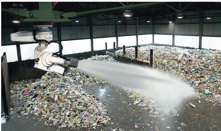
Abb.: Die Rosenbauer Werferlöschanlage schützt einen Anlieferungs- und Lagerbereich.
