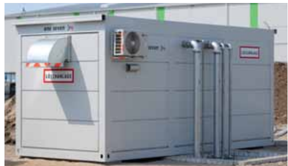
Löschanlage in Containerbauweise: da der Platzbedarf in Hallen oft begrenzt ist, wird die Löschanlage im Container installiert
