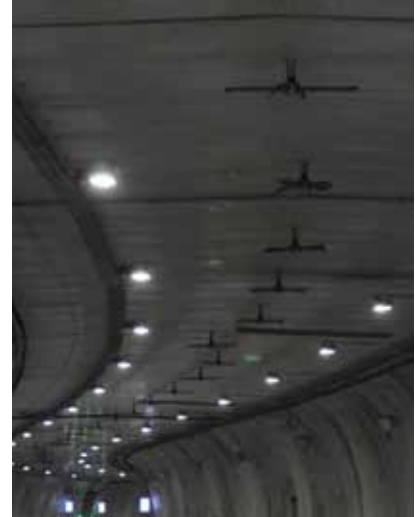
Installation der Rotore
