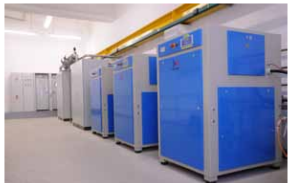
Löschanlagenzentrale
