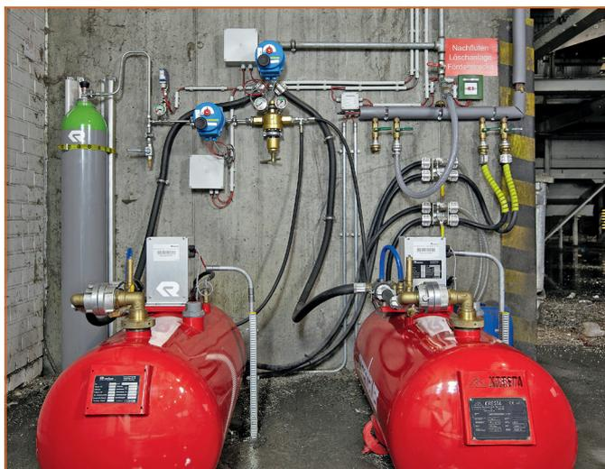
Abb. 2: Als zweite Löscheinheit fungiert eine autarke Löschanlage.
